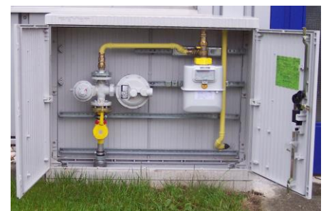
Bild 3: Gasanschlusses-Übergabestation
