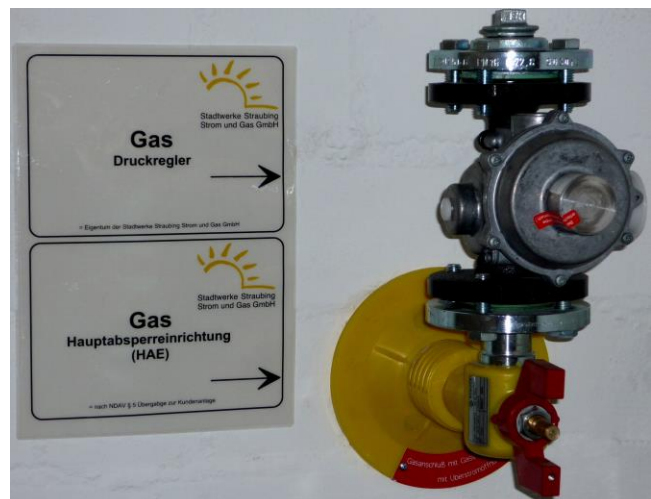
Bild 2: Hauptabsperreinrichtung mit Druckregler im Keller
